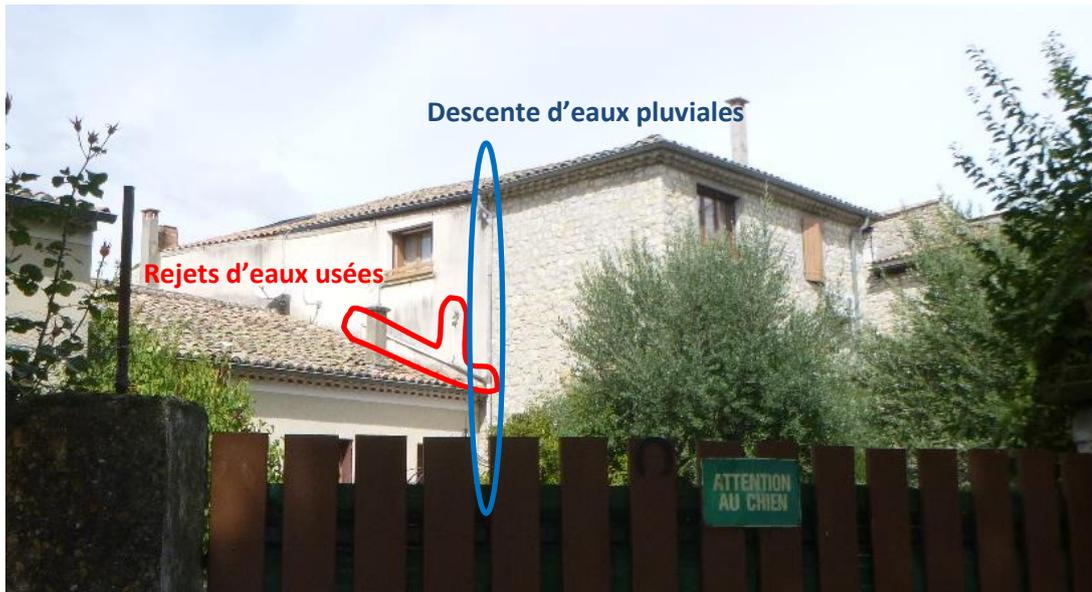
Après ouverture du regard au pied de la descente d'eaux pluviales, il s'avère qu'aucune modification n'a été faite depuis le dernier constat : les rejets de la salle de bain de l'appartement vont dans la descente, puis dans le réseau d'eaux pluviales de l'Allée des Platanes, transitant par la grille n°7. L'extrait cartographique ci-dessous retrace le cheminement des évacuations.
