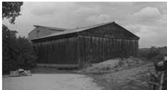
Il était nécessaire, après 38 ans d'existence, de remplacer le bardage bois de l'atelier de menuiserie par un nouveau en lames de douglas plus épaisses. Celui-ci se prolongera sur l'extension, déjà réalisée, qui ne pouvait rester en l'état sans protection. Ce chantier sera réalisé par le menuisier, Sébastien Mariau dont la qualité du travail est reconnue.
