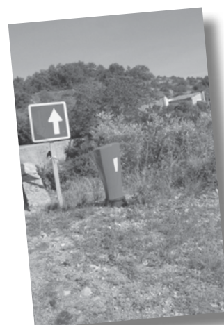
Borne incendie refaite à neuf
