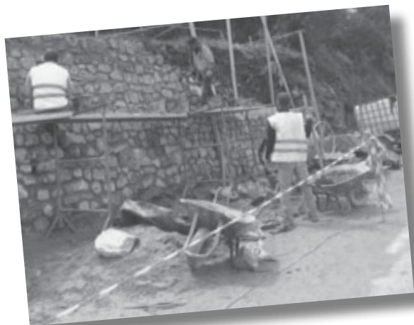
Mur de soutènement de Reboul rebâti
