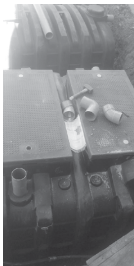
Fosse septique dernier cri ! Pour l'atelier communal
