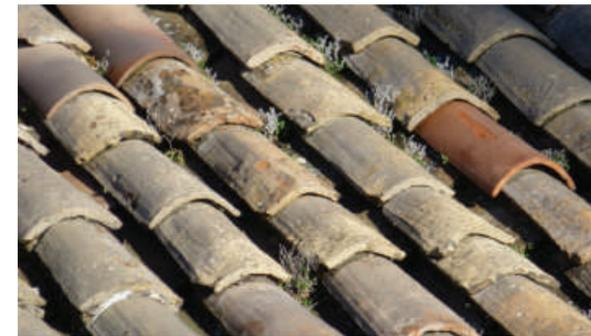
Les tuiles canals de courant et de couvert s'adaptent aux déformations de la charpente
