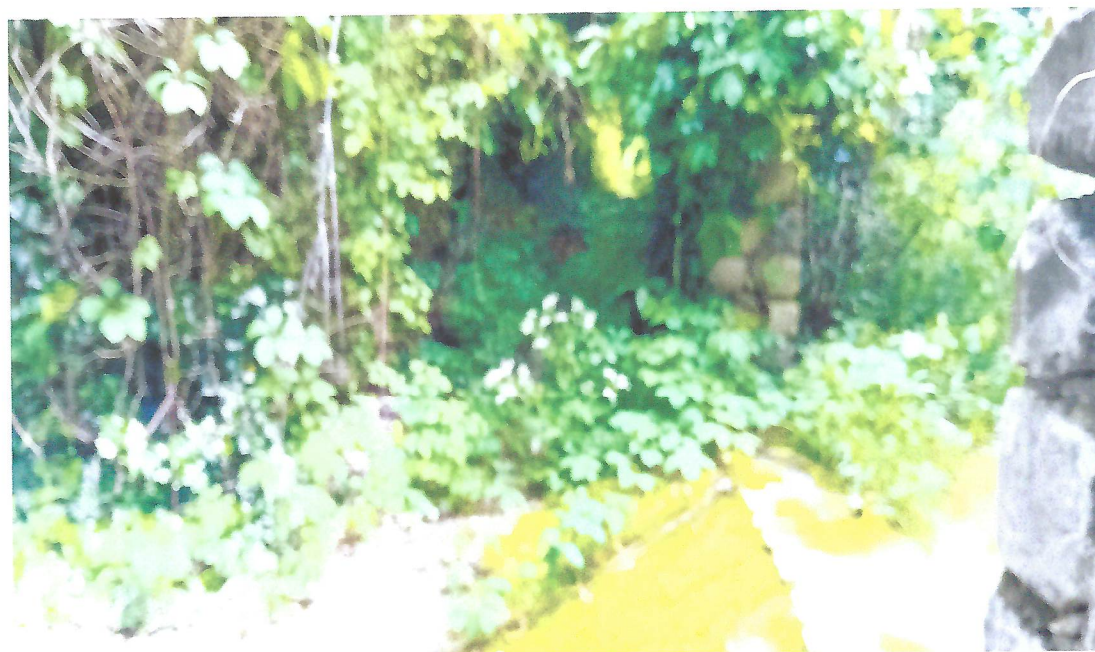
Débouché du chemin communal sur le ravin de la Charevaret. A droite, angle de la maison Chelinski. Une épaisse végétation encombre le ravin, le rendant très difficilement praticable
