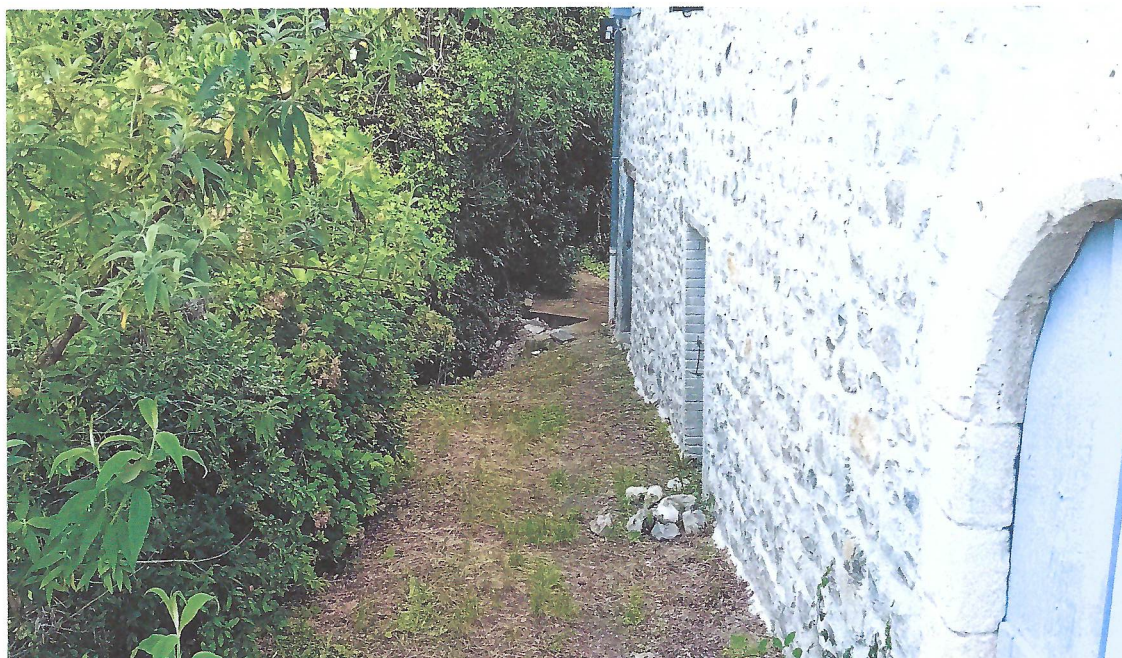
Vue de la portion de chemin objet de la procédure de déclassement avant aliénation. Le cliché est pris de l'angle bâti de la propriété Chelimski (à droite). A gauche, parcelle E 34 appartenant au même propriétaire.
